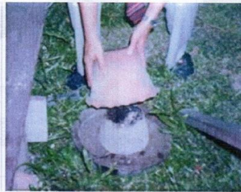
ตักกากไขมันจากบ่อดักไขมันใส่ในภาชนะ โดยที่กันภาชนะรองด้วยกระดาษทิชชู
